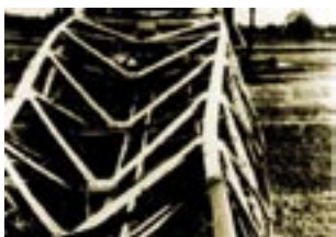
Zničený stožiar vysielača v Bratislave – Prievoze. (1945)
